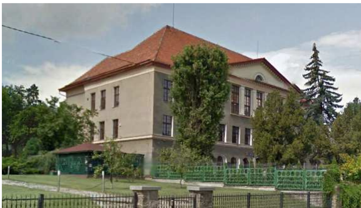
Fot.1 Zdjęcie elewacji frontowej
