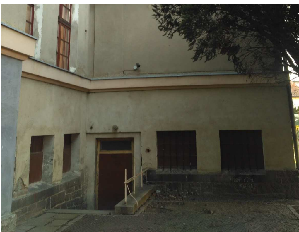
Fot.2 Zdjęcie elementów przewidzianych do zamurowania
